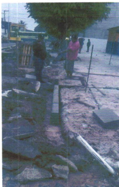
ASSENTAMENTO DE MEIO FIO
