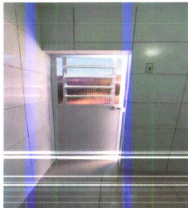
FOTO 26 PINTURA COM TINTA ALQUÍDICA DE ACABAMENTO
